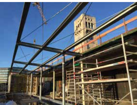
Stahlkonstruktion für die Gastronomie.
