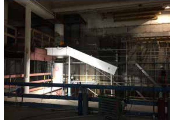
Treppe in der Luft- und Raumfahrthalle.
